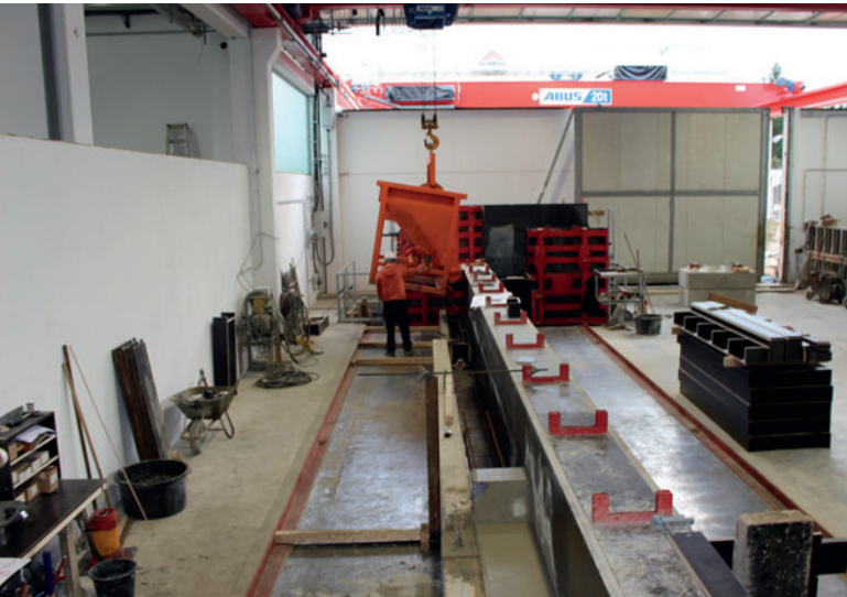
Eine der beiden neuen Stützen-und Balkenschalungen von Avermann
