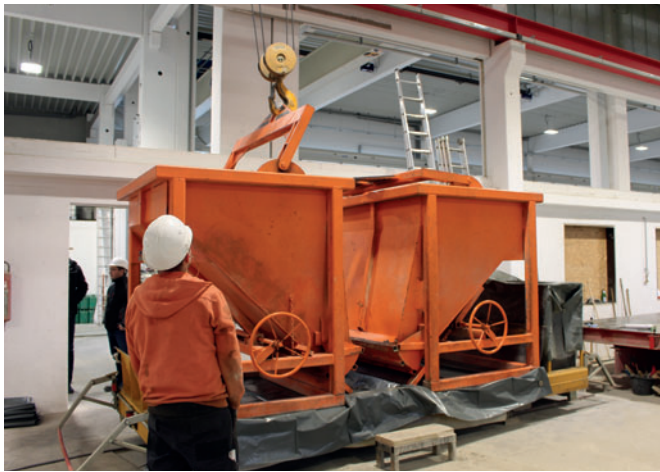
Mittels Kran werden die Betonkübel dann zum Einbauort befördert.
