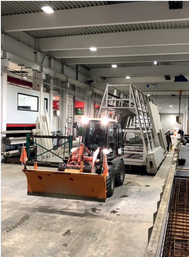
Die Fertigteile werden mit drei Schwerlastwagen mit A-Böcken von Kampa in das Außenlager transportiert.
