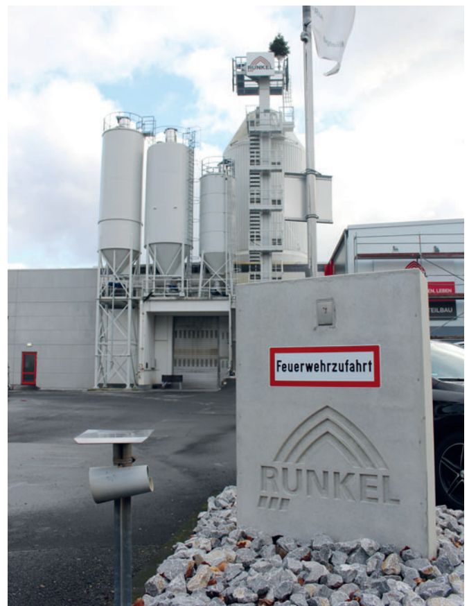
Das Fertigteilwerk von Runkel in Siegen
