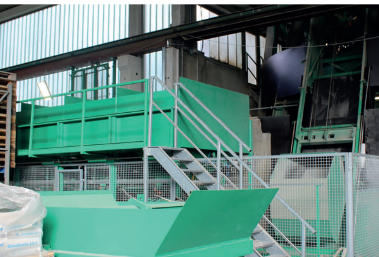
Reihensilo (4 Kammern) und Spezialaufzug
